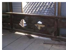
図5 透かし彫りのある欄干 Fig.5 The Law Fretwork Balustrade
