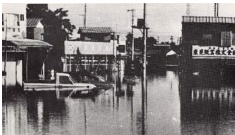
台風4号による浸水被害（埼玉県志木市 1966（昭和41）年6月）
