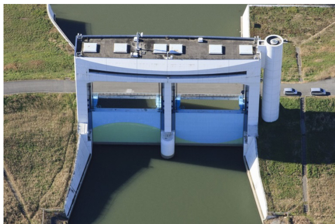
朝霞調節池の下流にある朝霞水門
