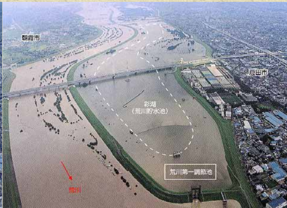
洪水時の荒川第一調節池
