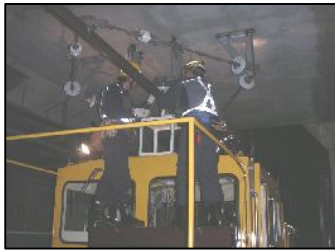
架線摩耗検査
