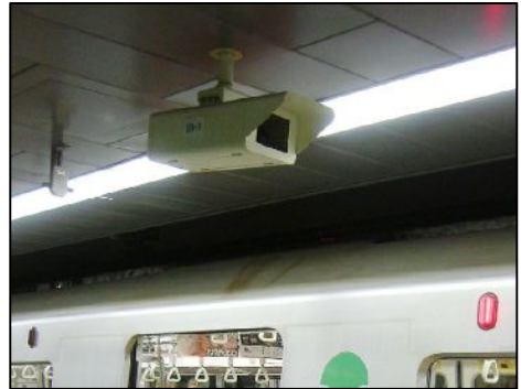
運転用監視カメラ
