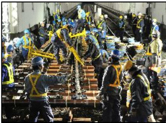
ポイント交換工事
