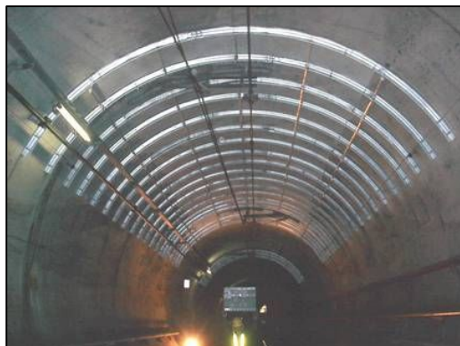
シールドトンネルのはく落対策工事
