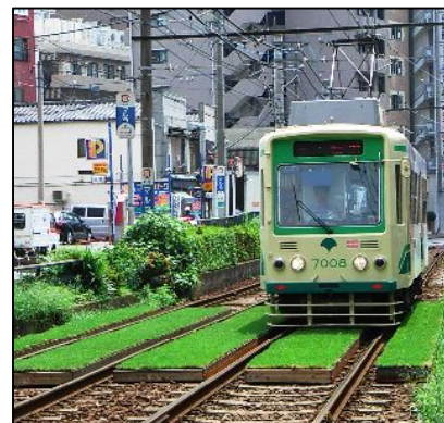
大塚駅前付近での軌道内緑化の実証実験
