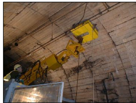
トンネルの現状調査
