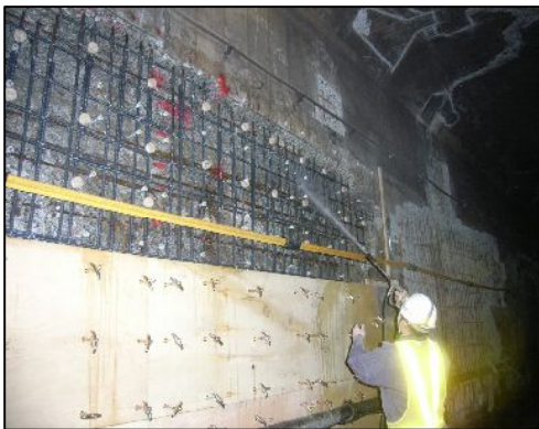
塩害を受けた日本橋川河底部構築の補強工事
