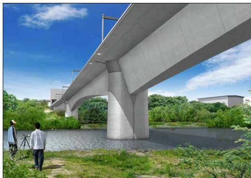
広瀬川橋りょう(西公園側から)
