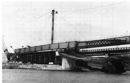
写真-1 架設全景
