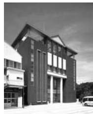
平成10年1月 体育・武道館
