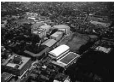
昭和42年 世田谷校舎全景
