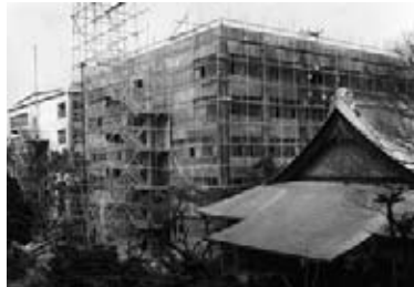
昭和38年 建設中の7号館
