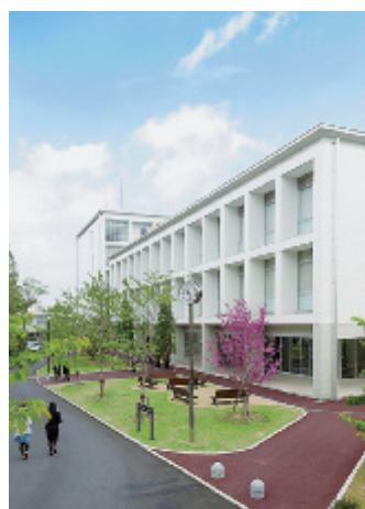
平成22年8月末に完成した教育研究棟(6・7・8号館)
