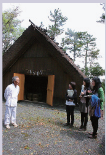
御塩殿にて焼き固めの奉仕にあたる喜多井さんに説明を受ける。奥の建物は御塩汲入所。中には12個の壺が置かれている。地面からすぐに萱屋根がふかかれているが、これは「天地根元造り」と呼ばれる貴重な建築様式。
