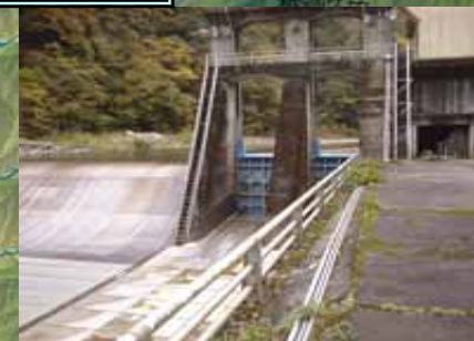
川原樋川取水堰堤
