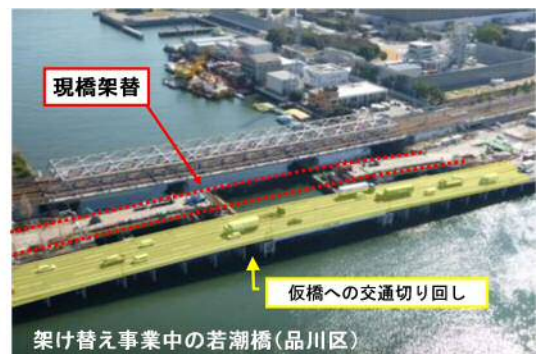
<災害に強い橋梁の整備>
