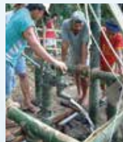
▲キロキロ小学校 井戸ポンプ完成
