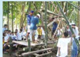
▲バグバグ小学校 井戸掘削中
