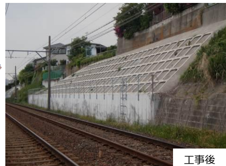
法面補強工事の一例 (検見川～京成稲毛間)
