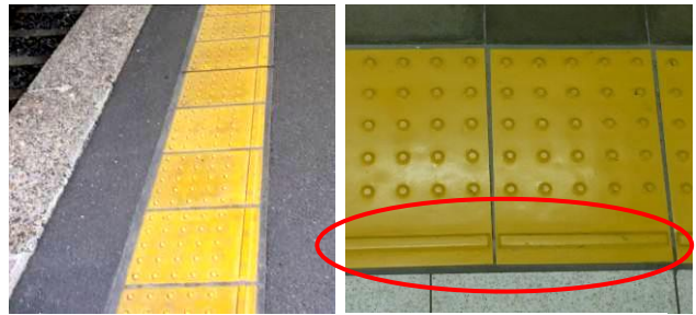
▲内方線付点状ブロック
