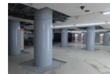
平和島駅構内高架橋
