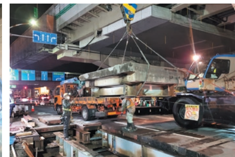
産業道路部分の踏切版の撤去
