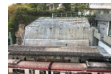
追浜駅構内法面防護工事
