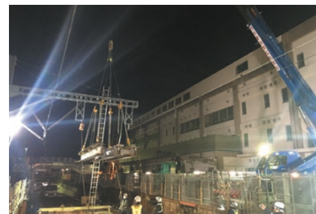
東門前駅付近の仮橋の撤去
