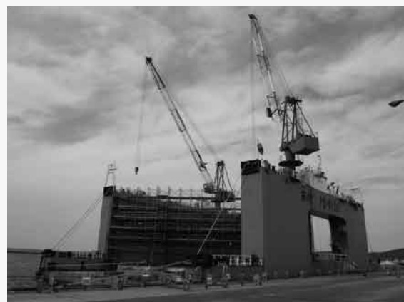
ウトロ漁港ケーソン製作工事
