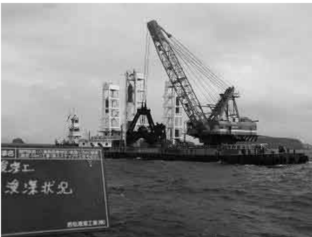
関門航路(六連島西側地区)浚渫作業
