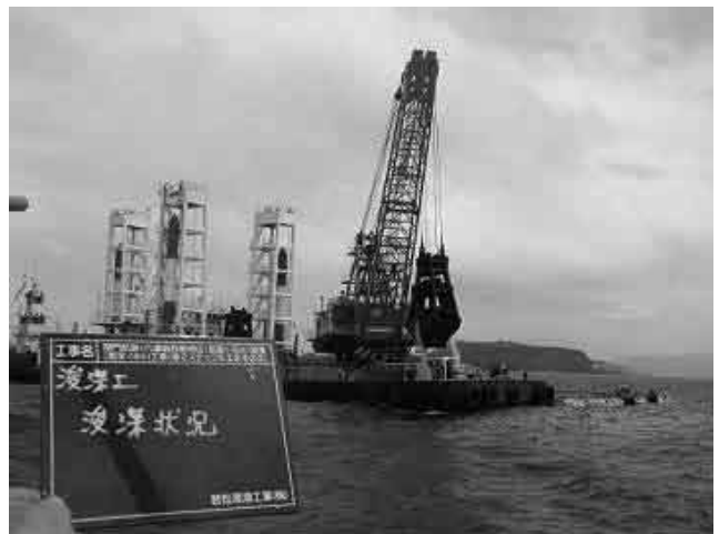
関門航路(六連島西側地区)浚渫作業
