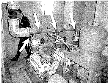
ステンレス管の溶接部分に発生した錆
