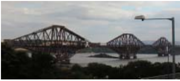
写真2 補修工事中のフォース橋 鉄道橋、アーチリブの修復中の石造アーチのディーン 橋(T.テルフォード、1832年)、フォース・クライド運河、
