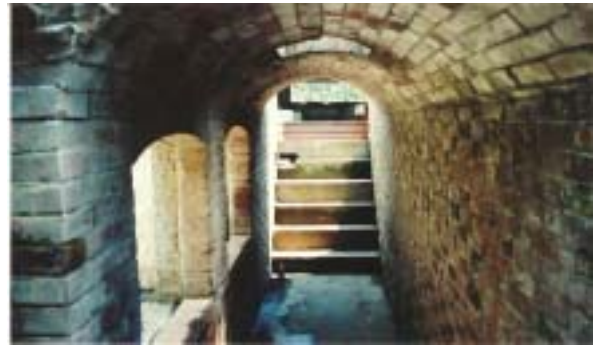
フランス積側壁の地下通路
