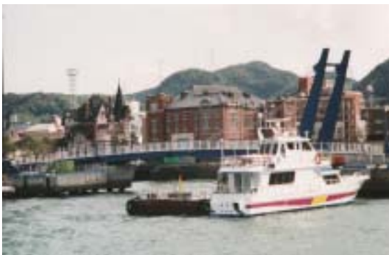
駅舎、船だまり、事務所等の土木・建築等の近代化遺産 そのものを現在にも生かしてまちの活性化を促した
