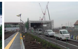
新幹線工事風景(渡島大野駅)
