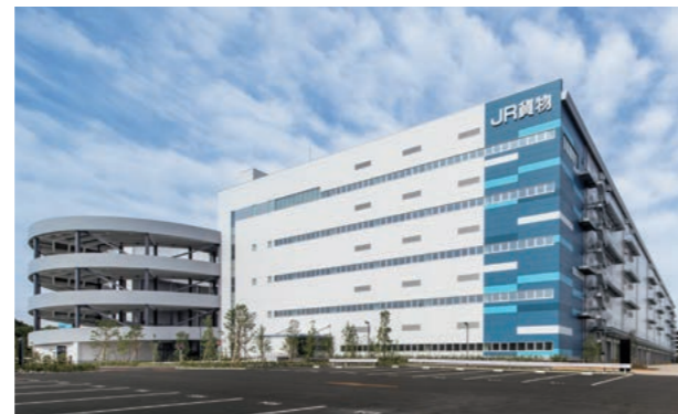
東京レールゲートEAST
