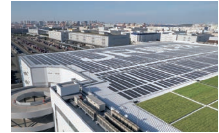
東京レールゲートEASTのソーラーパネル
