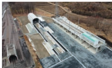
新幹線大規模改修に向けた実物大の模擬設備
