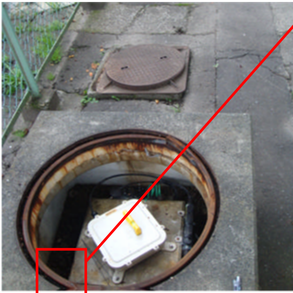
震度計を収納枅 (蓋が数 cm 左側にずれた)
