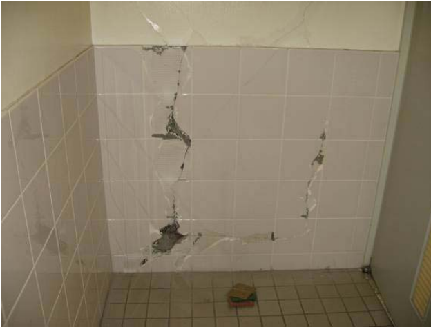
洋野町役場大野庁舎（北東側 所々内壁に亀裂あり）
