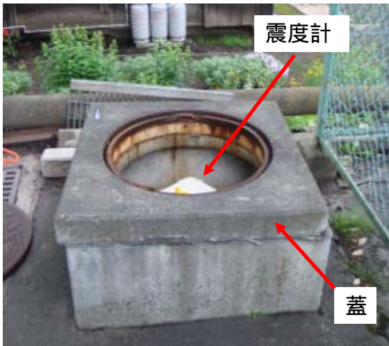
震度計を収納枅 (蓋が数 cm 左側にずれた)
