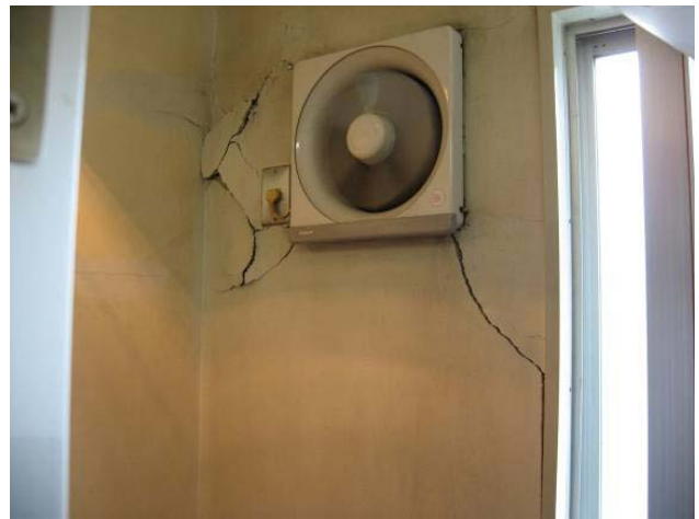
洋野町役場大野庁舎（北東側 所々内壁に亀裂あり）
