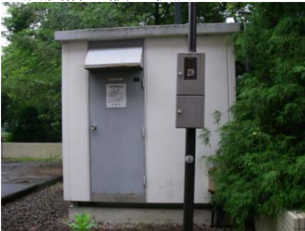
観測局舎の状況 (壁面・基礎の被害なし)
