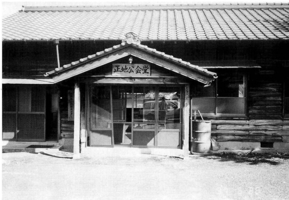
写真-7 正地地区 公会堂の玄関の戸が外れガラスが割れている。
