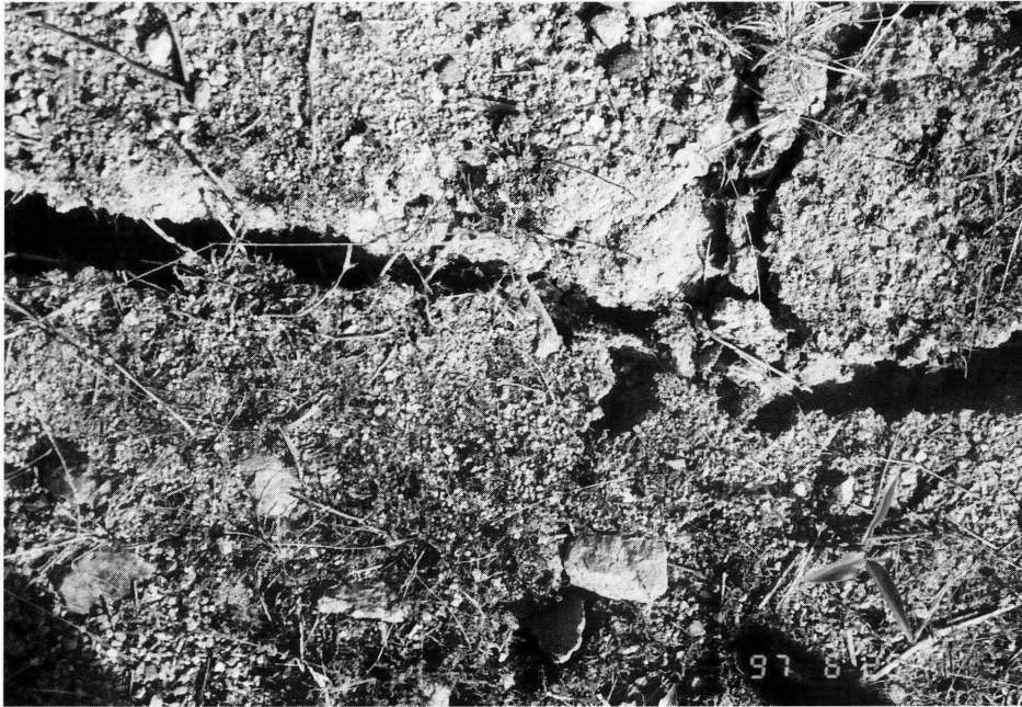
写真-5 田野地区 畑に地割れが起きる。
