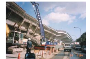
1995年 兵庫県南部地震 (The 1995 Southern Hyogo Prefecture Earthquake)
