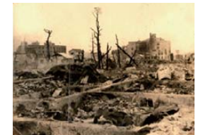
1948年 福井地震 (福井市) (The Fukui Earthquake)
