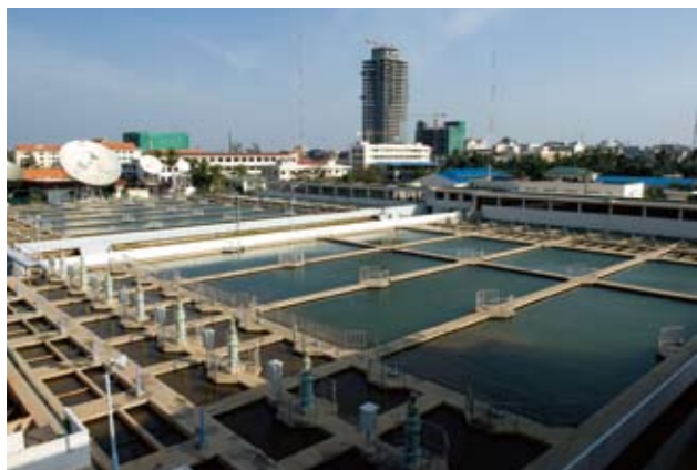
日本の支援で整備されたブンプレック浄水場。約55万人が安全な水を利用できるようになった
