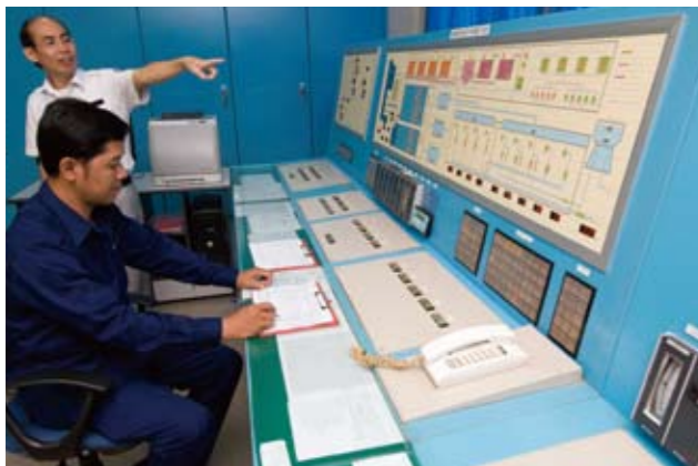
ブンプレック浄水場のモニター室では、24時間体制で全システムが管理されている
