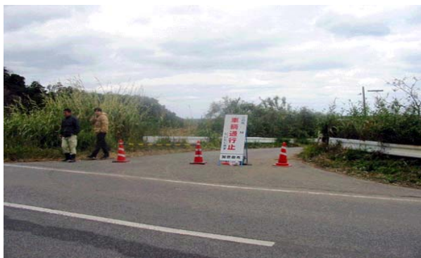
写Ⅱ-5 現場周辺での交通整理
