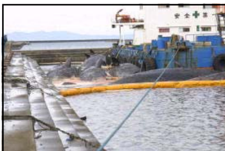
写VII-3 オイルフェンスの設置
