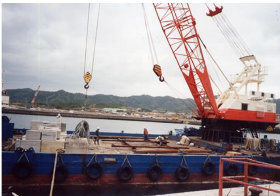
写VI-8 漁港に台船に係留。方塊ワイヤ等の積み込み。
