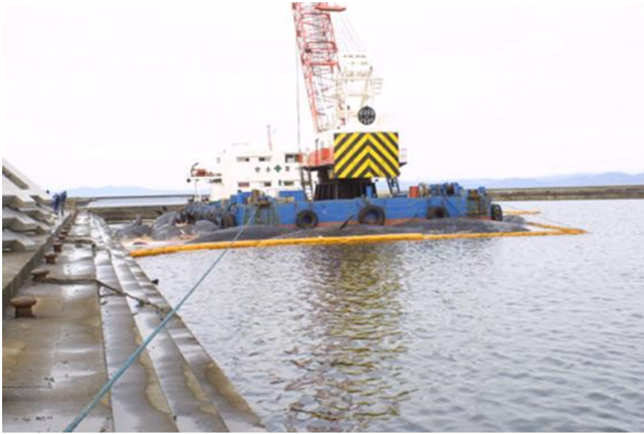
写 VI-10 オイルフェンスの設置
