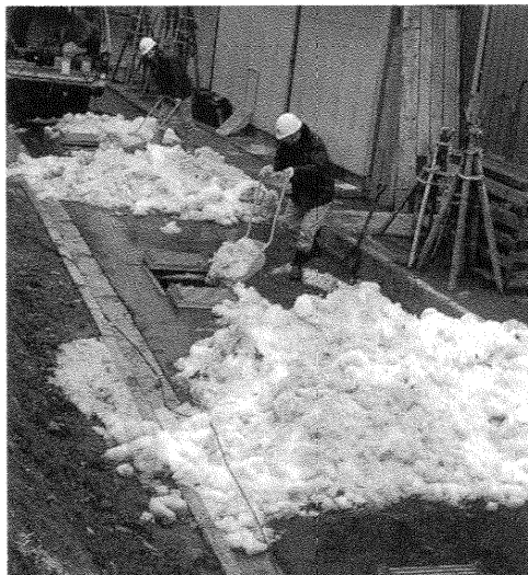
写真5 流雪試験の状況
