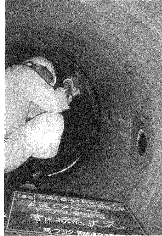
写真3 カーブ推進用ディスタンスピース取り付け
