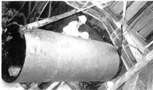
写真2 管の吊り降ろし
