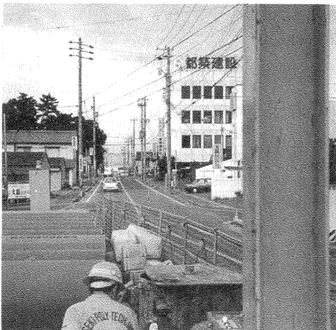
写真1 施工現場状況
