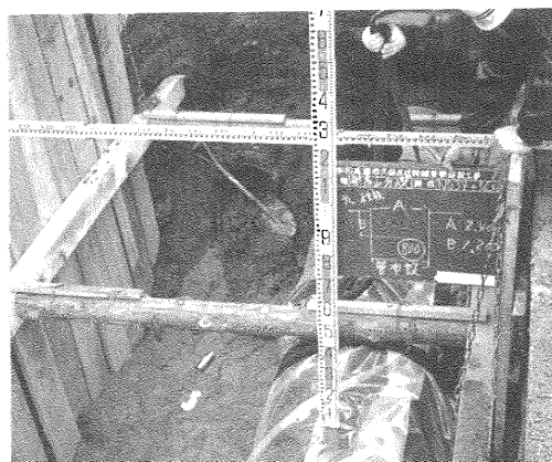
写真2 ダクトイル鉄管埋設工事
