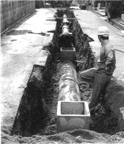
図7 雨水および1次処理された生活排水の引き込み管の設置状況
