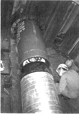
写真4 推進機とのジョイント
