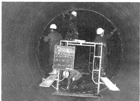
写真6 管内接合状況
