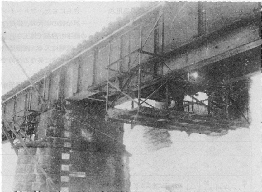
写真-1 鉄道桁のT形補強の溶接状況 6)
