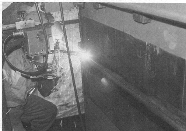
写真-3 橋脚柱のCO 2 アーク溶接
