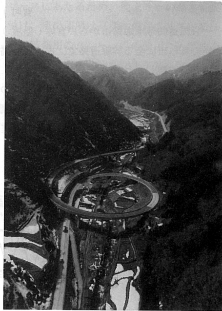
ループ橋の全景
