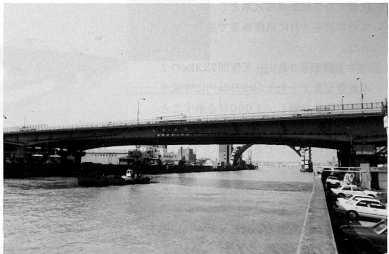
安治川大橋 (下流側 大阪方から神戸方を望む)
