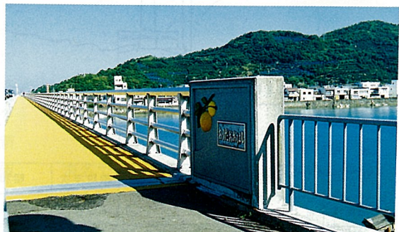
みかん色の歩道舗装とみかんをデザインした親柱
