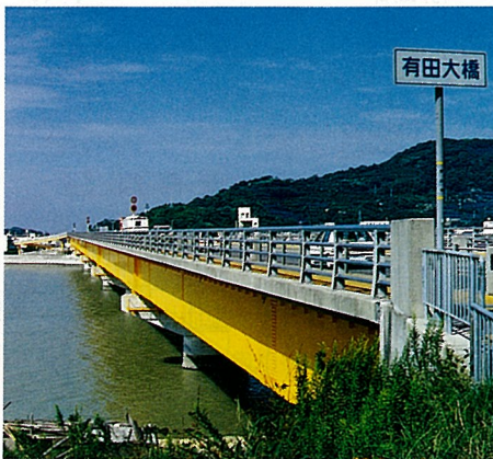
有田大橋 — みかん色の塗装 —
