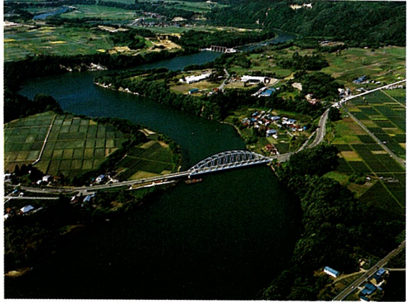
トラスドラングアー桁形式では東洋最長
