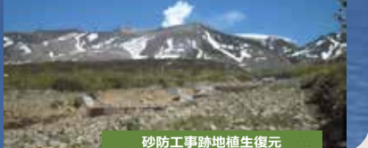
砂防工事跡地植生復元
