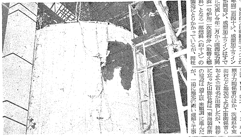
三、五、上部スラブ厚〇・五五、プレストレスト導入方式は、上から下部へ、らせん状に入れている。
