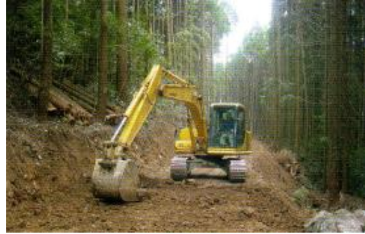
【図表 4-3-3 作業路の開設】
