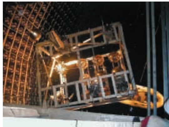
図5 実装されたフレームを水中に降ろす
