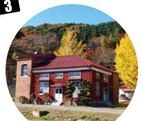
旧町屋変電所 (常陸太田市)
