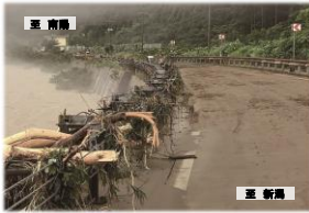
▲令和4年8月豪雨による被災状況
