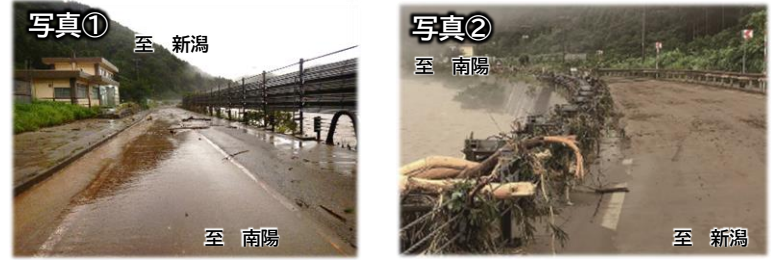
〔国道113号 関川村金丸地先 (R4.8.4) 〕
