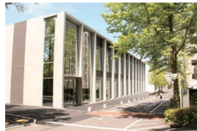
27 フロンティア研究棟
