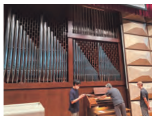
パイプオルガンの修理を実施
