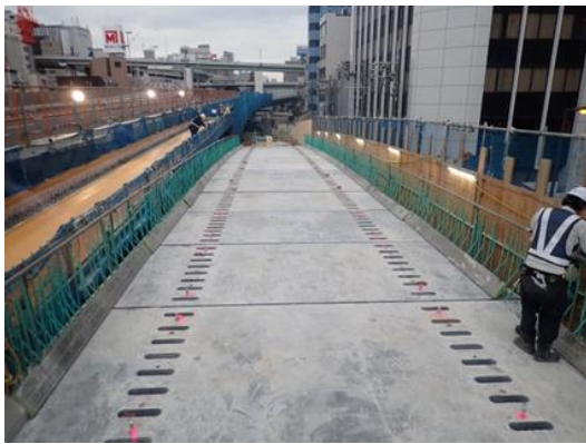
信濃橋入口に適用したワッフル型 UFC 床版 上面から（左）・設置状況（右）
