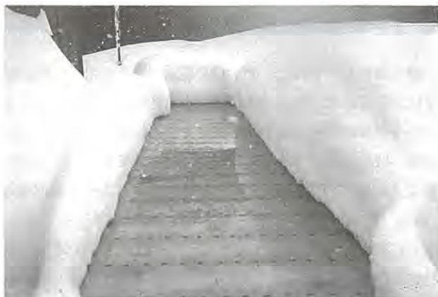
ヒートパイプ式消雪パネルによる消雪状況
