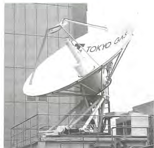
東京ガス(株)衛星通信本社局
