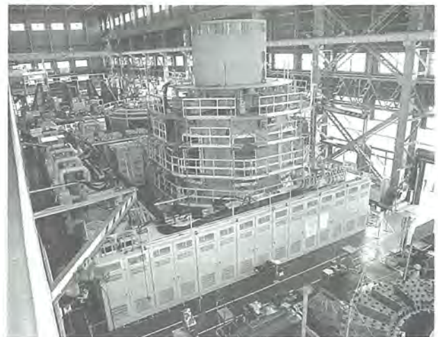
高見揚水発電所 2 号機工場組合せ試験
