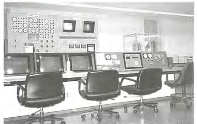
三菱マテリアル(株)苅田工場納め発電所統合制御システム MELTAS
