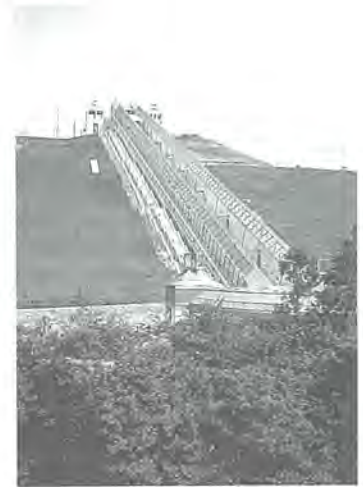
名塩地区斜行エレベーター
