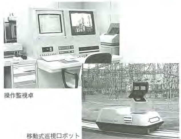
四国電力(株)讃岐開閉所向け自動巡視ロボット
