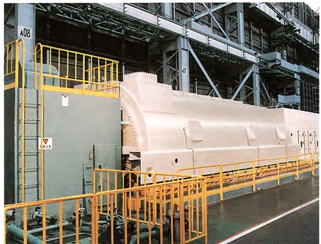
関西電力(株)南港火力発電所 | 号670MVA水冷却タービン発電機
