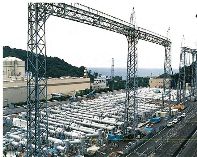
関西電力株大飯発電所550kV GIS据付け状況
