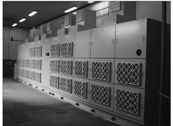
図4 大容量同期電動機用スタータ
