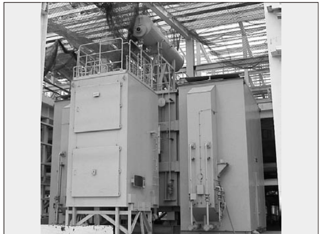
図2 台湾プラスチック向けソーダ電解用Sフォーマ
