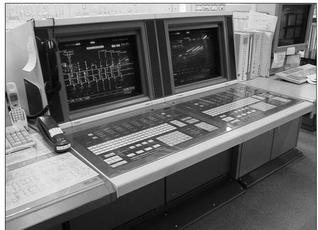
6 火力発電所設備の計測制御システム
