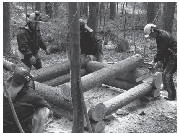
写真-5 間伐した丸太で小屋を作成中
