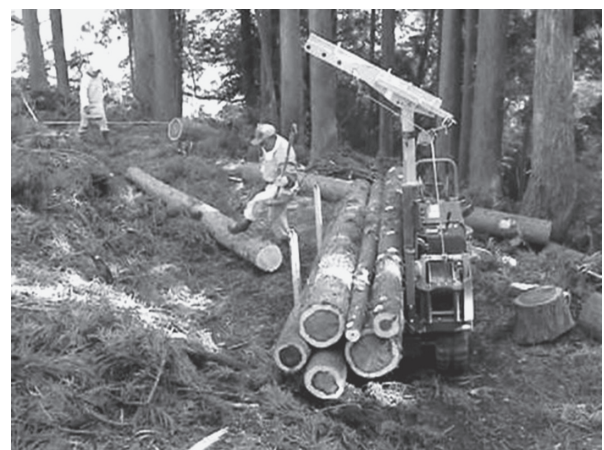
図-6 西岡式作業システム作業風景
