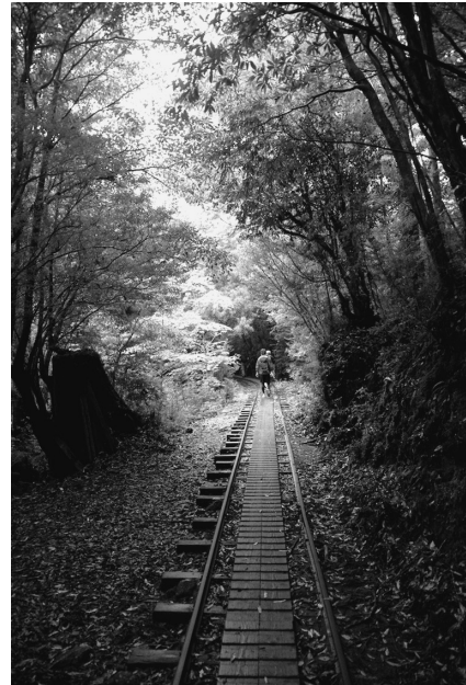
図-3 小杉谷周辺に現在も残る森林軌道跡 撮影：2012（平成24）年9月15日 注：地元住民の呼称として「軌道」を用いている。
