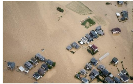
写真 5-7 孤立地区（提供：防災科学技術研究所）
