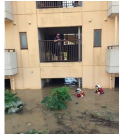
常総市千代田団地の浸水状況
