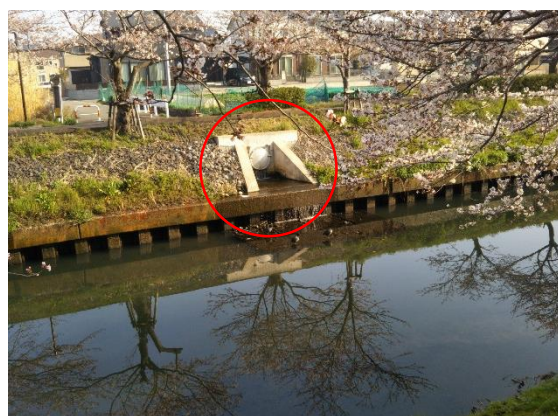
写真 3-15 水路の開口部
