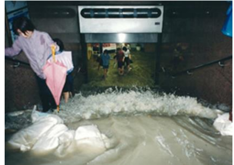
写真 5-12 地下浸水（地下鉄）
