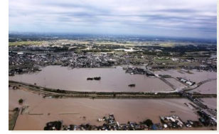
茨城県常総市 上空からの被害状況
