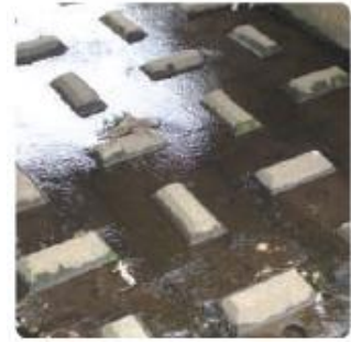
写真 3-14 床止工（出典：公共財団法人河川財団「水辺の安全ハンドブック」）
