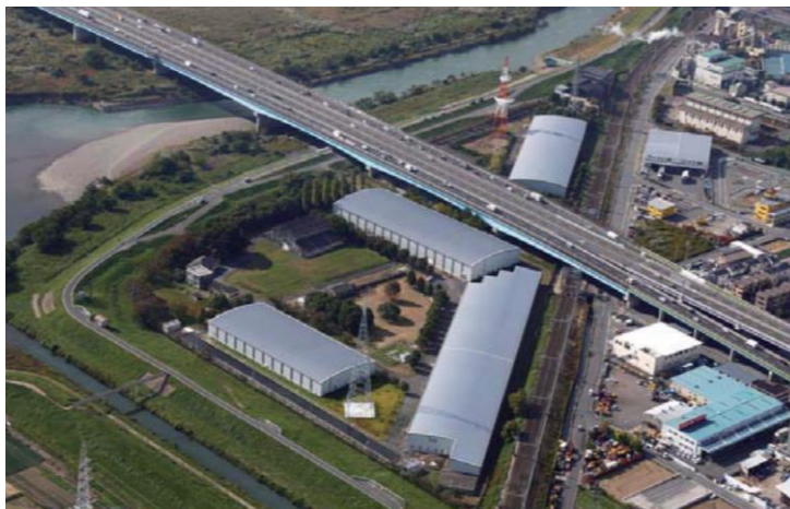
写真 施設外観
