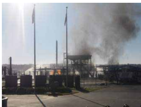
危険物火災訓練施設
