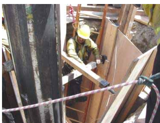
工事現場のトレンチ・レスキュー
