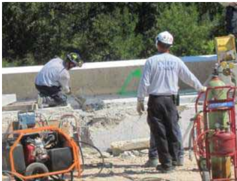
鉄筋の溶断
