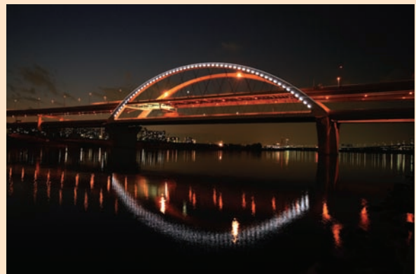
自動車の振動による発電でライトアップさせた高速道路の橋 (写真提供：首都高速道路株式会社)
