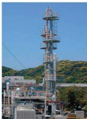
二酸化炭素回収長期実証試験プラント全景 (写真提供：三菱重工業（株）)
