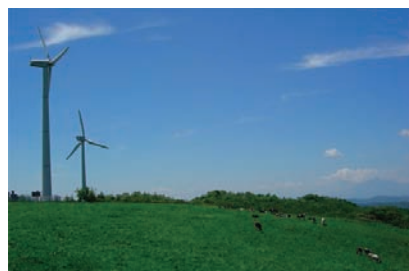
葛巻町の風力発電施設（写真提供：葛巻町）
