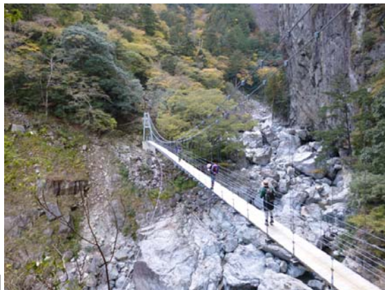
再建された平等岨吊り橋
