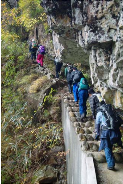
転落防止のためコンクリート階段を整備
