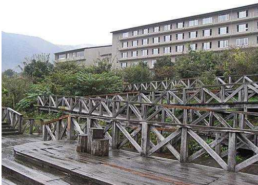
湖畔の展望施設まで車いすでも降りられる傾斜路であるが、景観への影響も大きい 富士箱根伊豆国立公園 田貫湖集団施設地区
