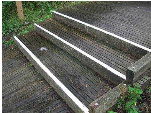
段差部を白のペイントで目立たせている
