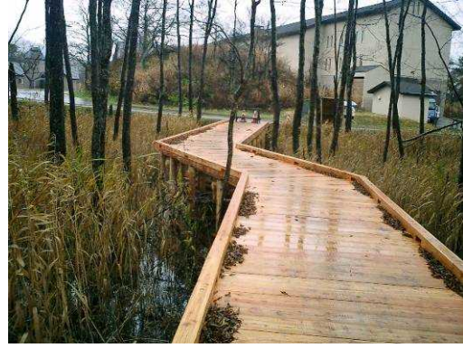
木道では落ち葉がたまらないよう隙間を空けて設置するのが望ましい
