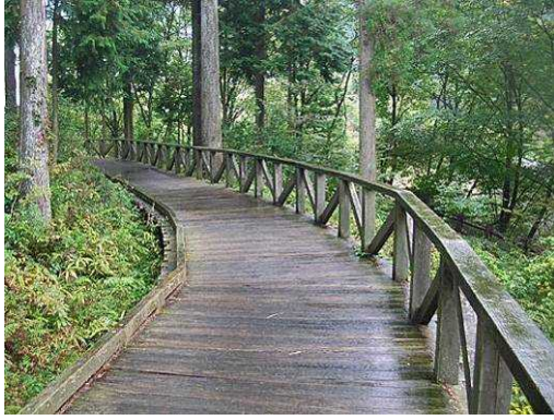
危険度に応じて、山側は立ち上がりを、谷側は防護柵を設置している
