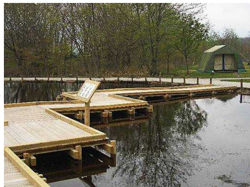
再整備後：車いす使用者も安全に利用しやすい構造の木道として再整備した
