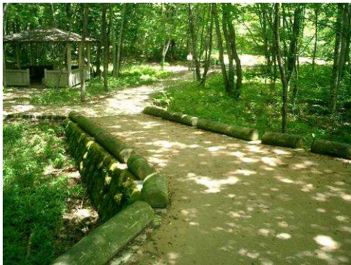
自然景観に配慮した丸太による路側処理
