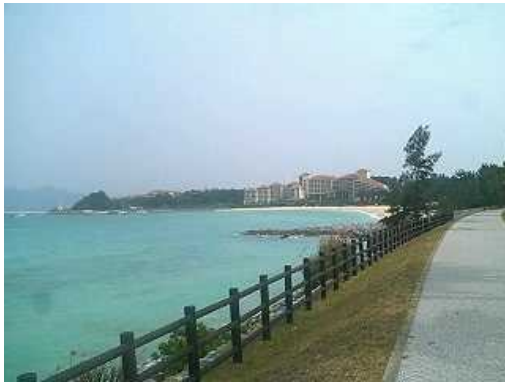
園路より低い位置に柵を設けることで景観に配慮している例
