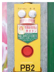
列車非常停止ボタン
