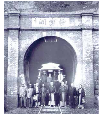
極楽寺トンネル開通 1907年(明治40年)
