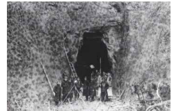
極楽寺側から見た掘削中のトンネル 1906年(明治39年)
