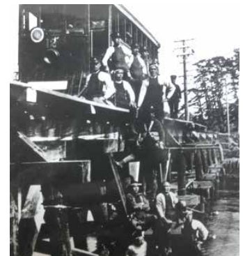
水害による境川橋梁の復旧作業 1920年(大正9年)
