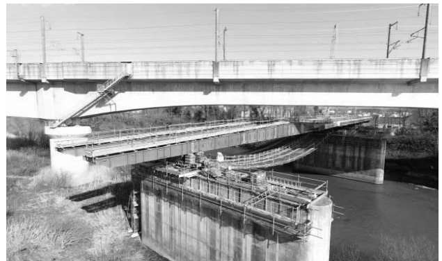
図-5 送出し架設状況
