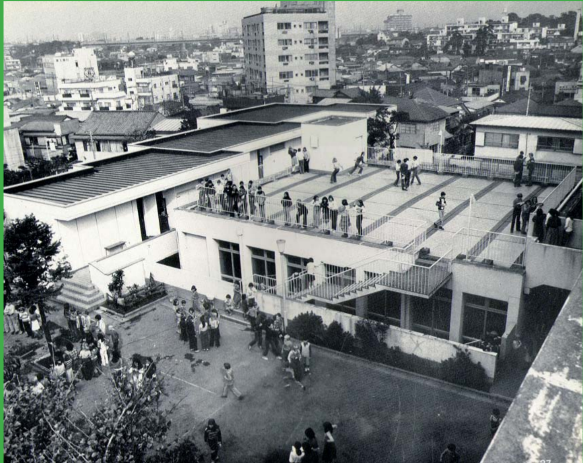
Das neue Schulgebäude aus dem Hinterhof nach dem Neubau / 後庭から見える新校舎 / The new school building seen from the backyard
