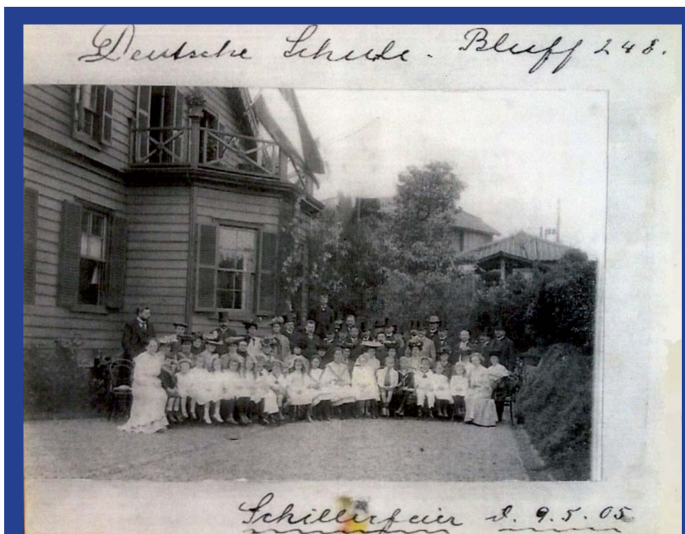
Das erste Bild der Deutschen Schule in Yokohama (1905) / 横浜ドイツ学園の最初の写真 (1905) / The first picture of the German School in Yokohama (1905)
