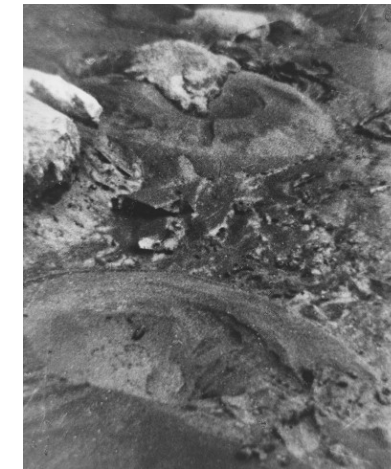
液状化による噴砂
