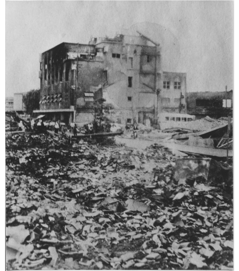
鳥取市内で倒壊を免れたビル。手前は倒壊し火災に襲われた木造家屋の残骸
